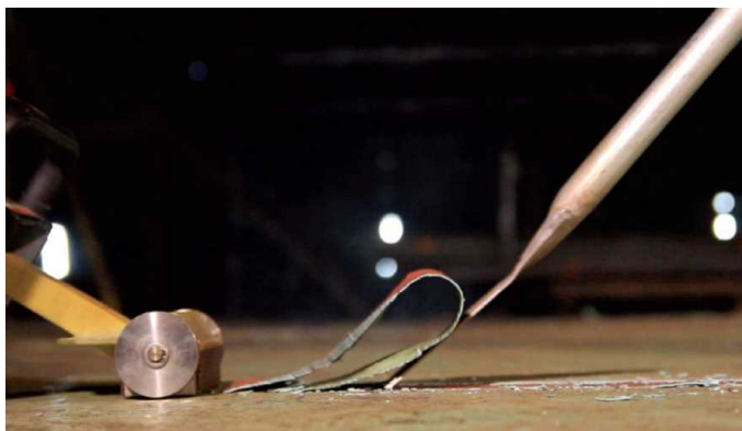
タンク内 ガラスフレークライニング剥離の様子
