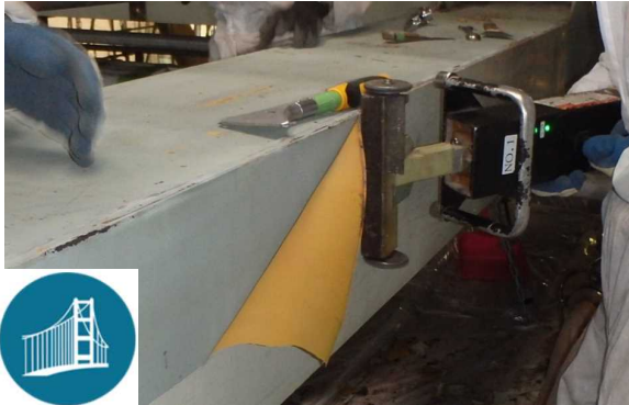
橋梁桁：防錆コーティングの剥離
