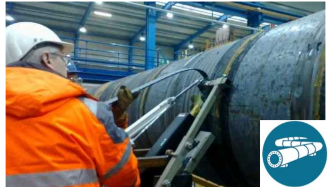
パイプライン：アスベスト含有コーティングの剥離
