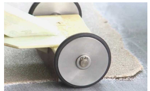
塗膜の上から、RPRで下地の鋼板を加熱
