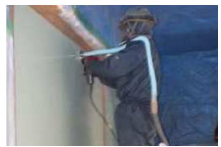
写真-5 剥離剤工法剥離剤施工時
