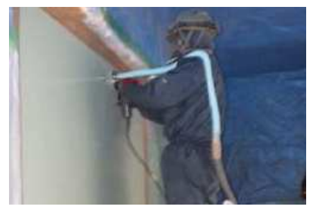
写真-5 剥離剤工法剥離剤施工時
