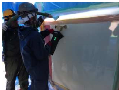
写真-3 IH工法施工時
