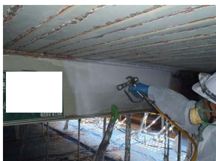
剥離剤 B 塗布状況
