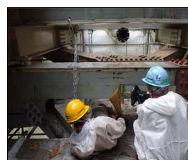
IH 工法施工状況
