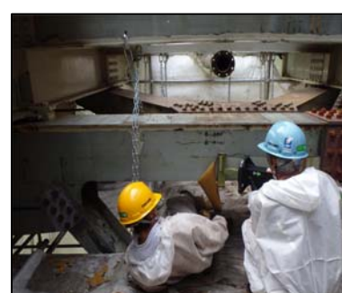
IH 工法施工状況
