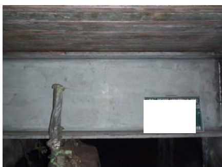
剥離剤 B 塗膜除去後
